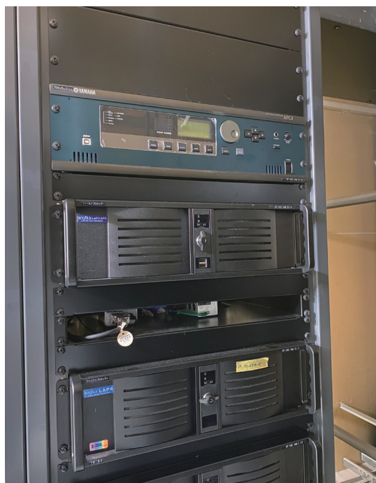
中ホール調整室のラックにマウントされているAFC3システム(上の2基)
