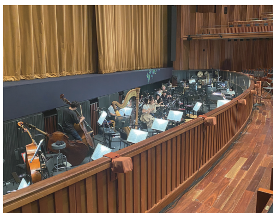
リップフィルとして仮設したMEYER MM4(茶系のサランでカモフラージュ)
