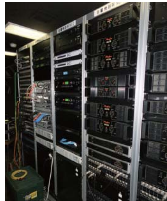
音響調整室内 奥から： 入力コネクター盤架 音響機器架 No1, 2, 3, 4
