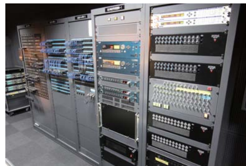
奥から：入出力パッチ架 -1, 2, 3、SE 卓信号処理架 -1, 2
