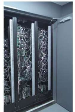
アンプ室外（廊下側）
